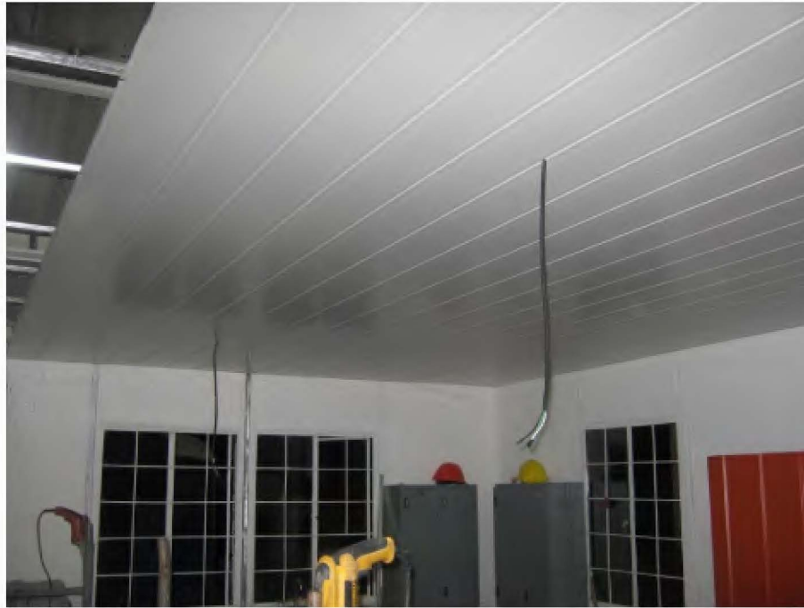
Figura 87 Cielo raso del contenedor de lectura
