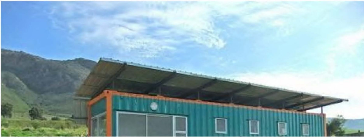
Figura 86 Techo del contenedor de lectura
